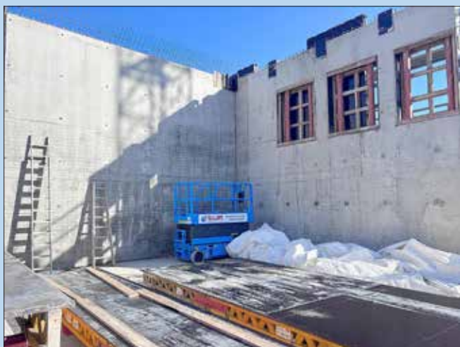
Betonierte Nordostecke der neuen Sporthalle
